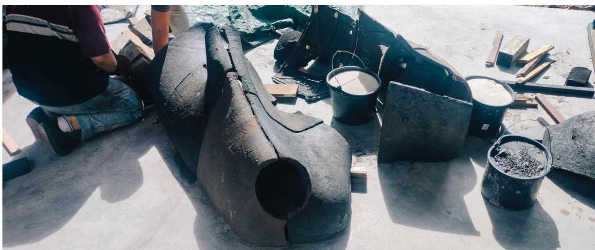
Üksikosade tervikuks sidumine, ettevalmistused keevitustöödeks. August 2024.
